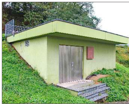
Der Wasserhochbehälter Kinzge wird saniert. Foto: Horst David
