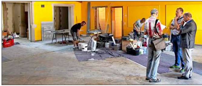
Behindertengerechte Toiletten werden installiert. Ein Bild vom Fortgang der Arbeiten machen sich (von rechts) Bürgermeister Dieter Schneckenburger und Ortsbaumeister Siegfried Brenn. Fotos: Horst David
