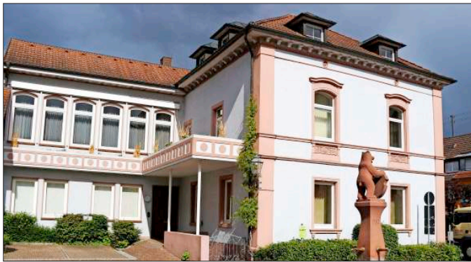
Das Rathaus Bötzingen wird ab Anfang Mai modernisiert.
