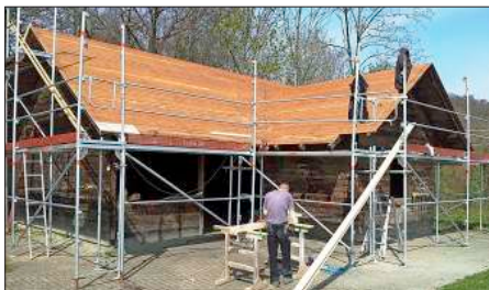
Blick auf die Dachsanierung der Hohrainbuckhütte.
